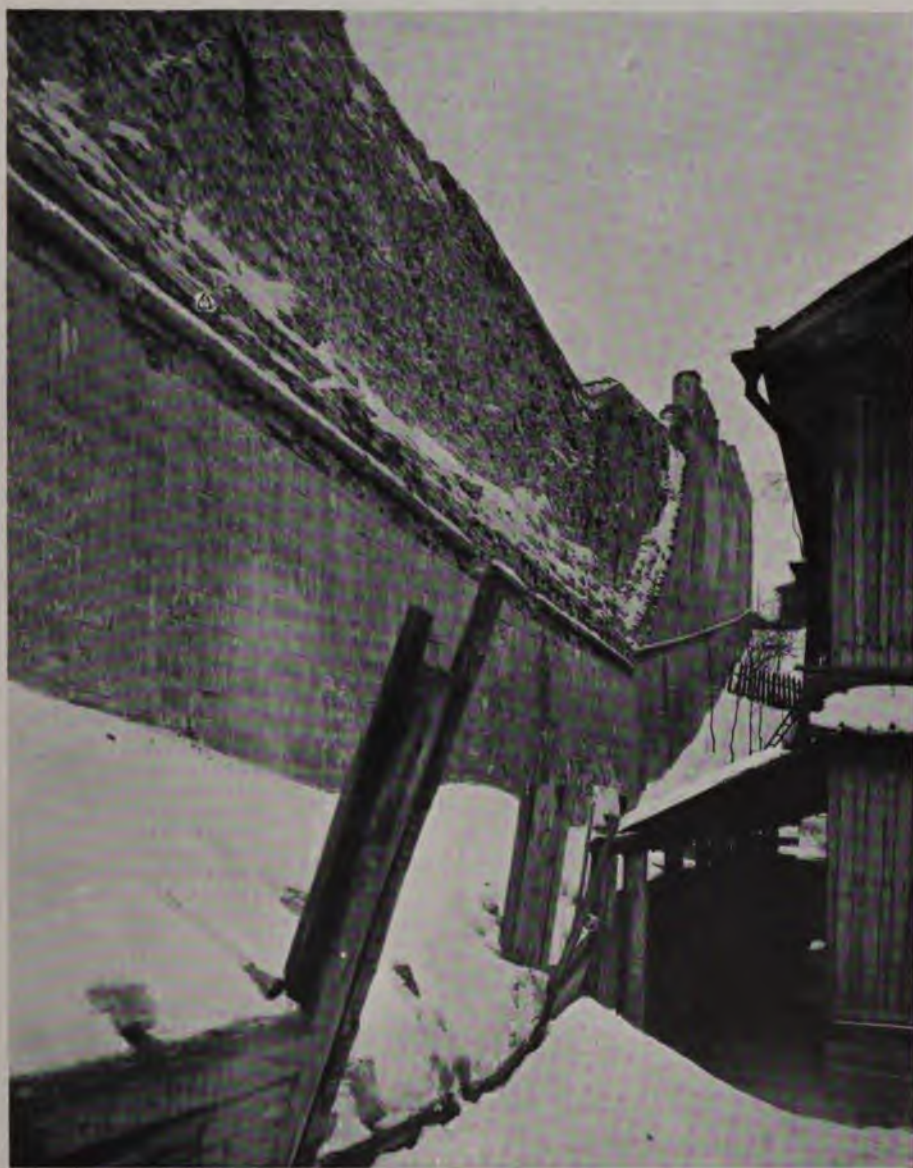
Разрушение стѣны путемъ оттаиванія.
